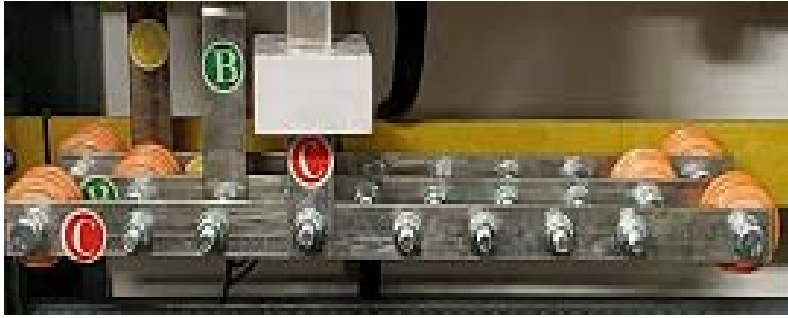
图 29 双电源控制设备电源出线端子
